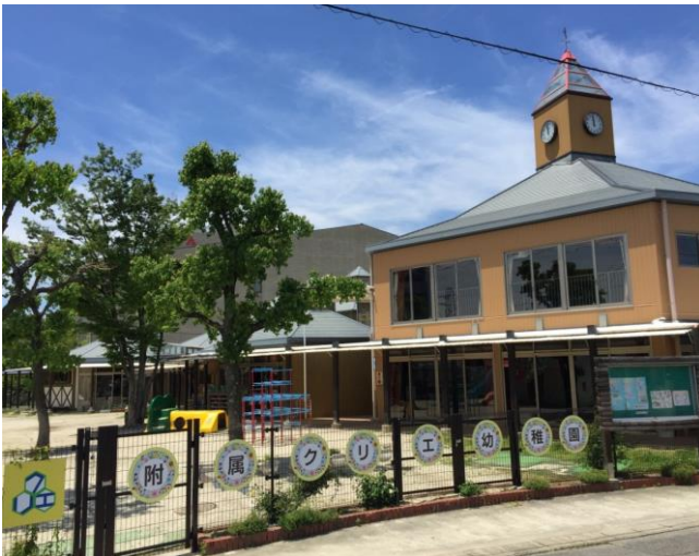
※1 平成27年度 校舎・園舎の硝子飛散防止フィルム施工 (非構造部材耐震)クリエ園舎
