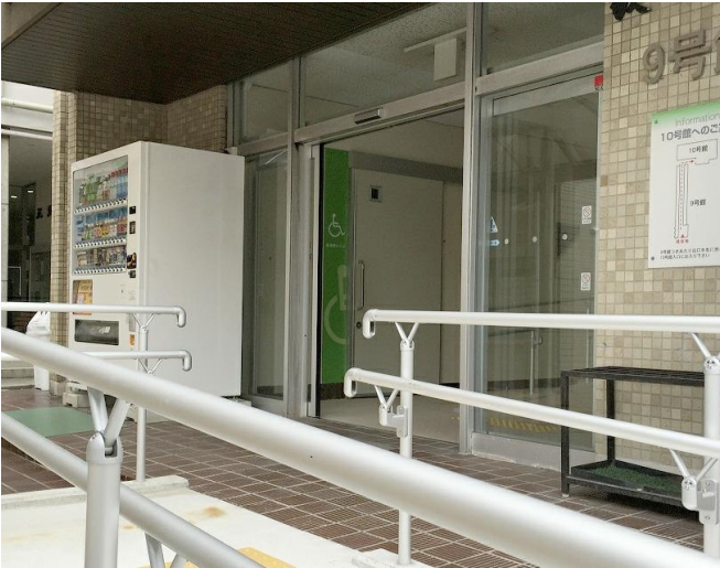
※3 平成26年度 東キャンパス 玄関自動ドア・スロープ・ 手摺・多目的トイレ改修(バリアフリー)
