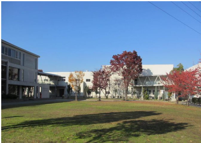
※7 平成17年度 西G・U棟渡り廊下増築(バリアフリー)
