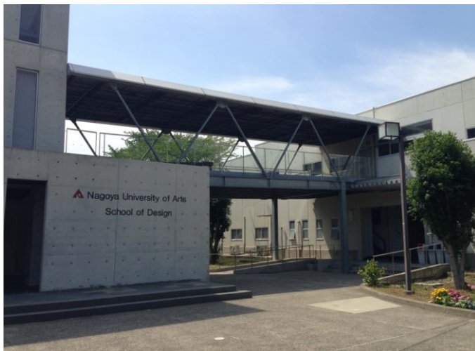
※9 平成16年度 西X・G棟渡り廊下増築(バリアフリー)
