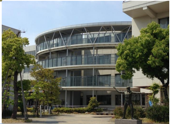
※8 平成17年度 西H・K棟エレベーター 渡り廊下増築(バリアフリー)
