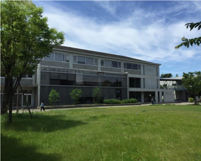
※1 平成27年度 校舎・園舎の硝子飛散防止フィルム施工 (非構造部材耐震)西キャンパスX棟
