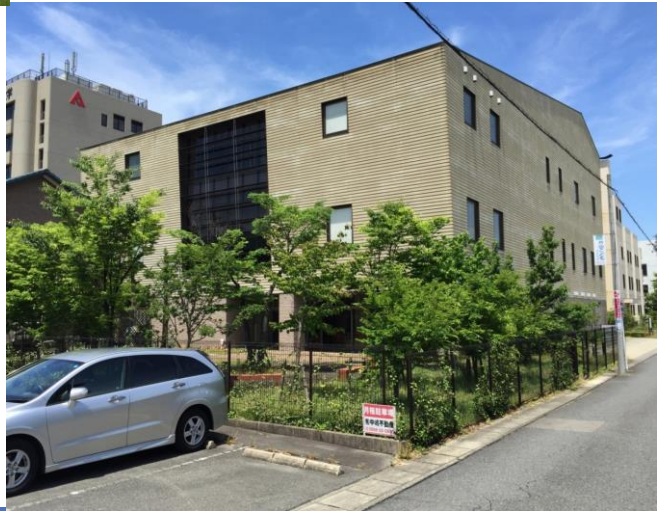
※1 平成27年度 校舎・園舎の硝子飛散防止フィルム施工 (非構造部材耐震)東キャンパス2号館
