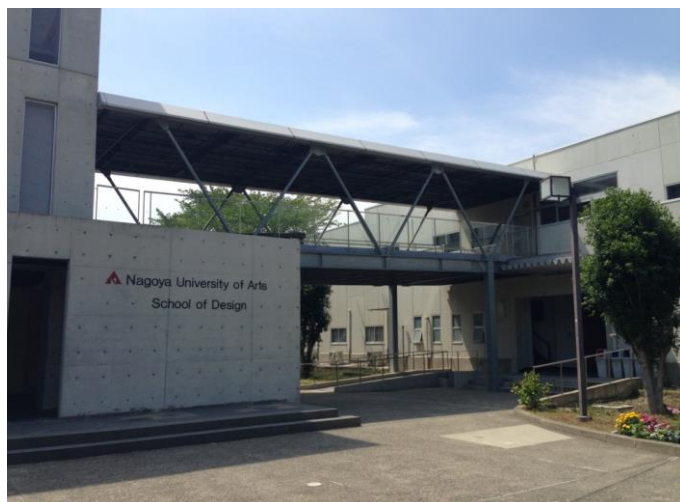
※10 平成16年度 西X・G棟渡り廊下増築(バリアフリー)
