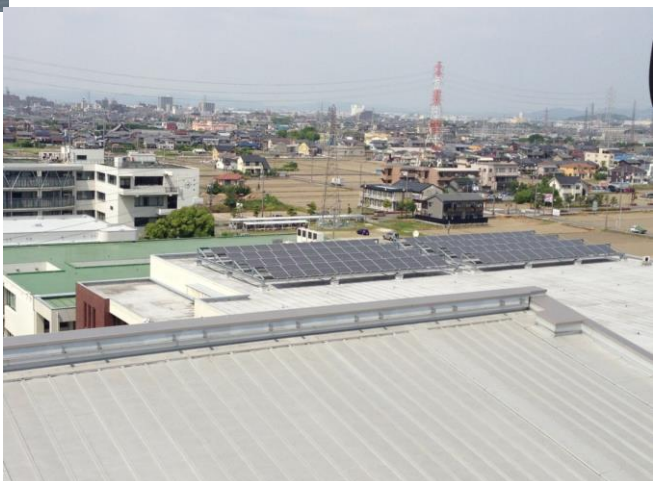
※4 平成22年度 西体育館屋上太陽光発電設備設置(40kw)
