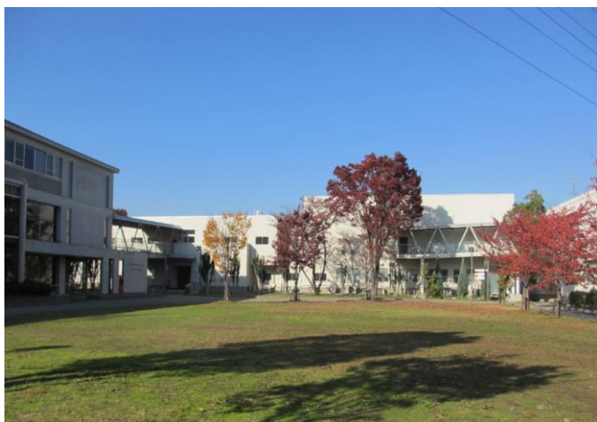
※8 平成17年度 西G・U棟渡り廊下増築(バリアフリー)
