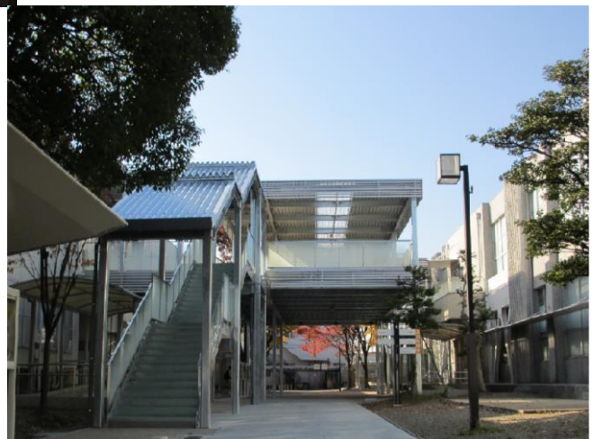
※7 平成24年度 西B・G棟渡り廊下増築 (バリアフリー)
