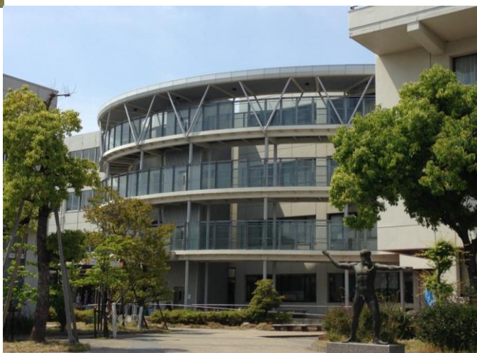
※9 平成17年度 西H・K棟エレベーター 渡り廊下増築(バリアフリー)
