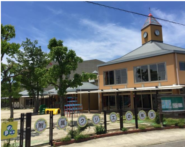
※2 平成27年度 校舎・園舎の硝子飛散防止フィルム施工 (非構造部材耐震) クリエ園舎
