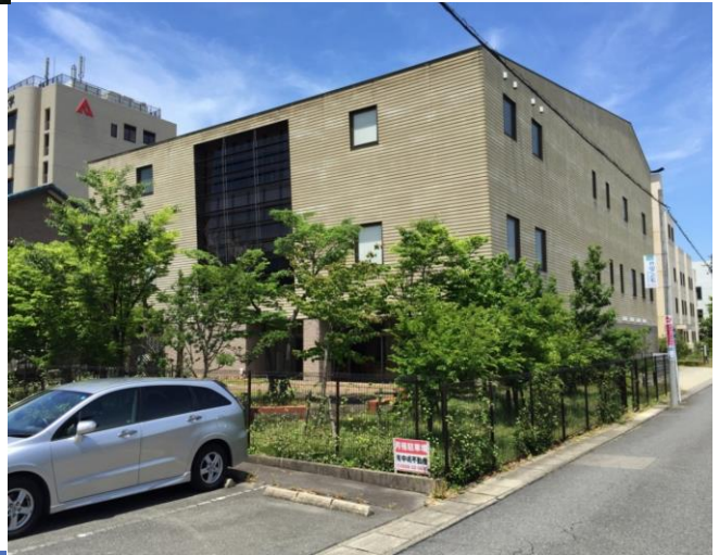
※2 平成27年度 校舎・園舎の硝子飛散防止フィルム施工 (非構造部材耐震) 東キャンパス2号館
